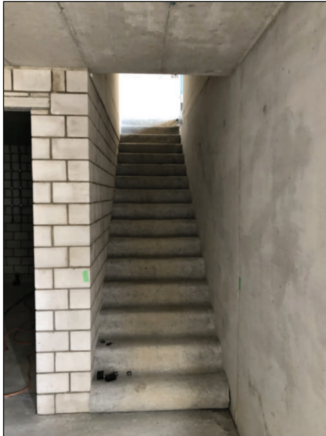
Zugang via Treppenhaus vom EG ins 1.OG
